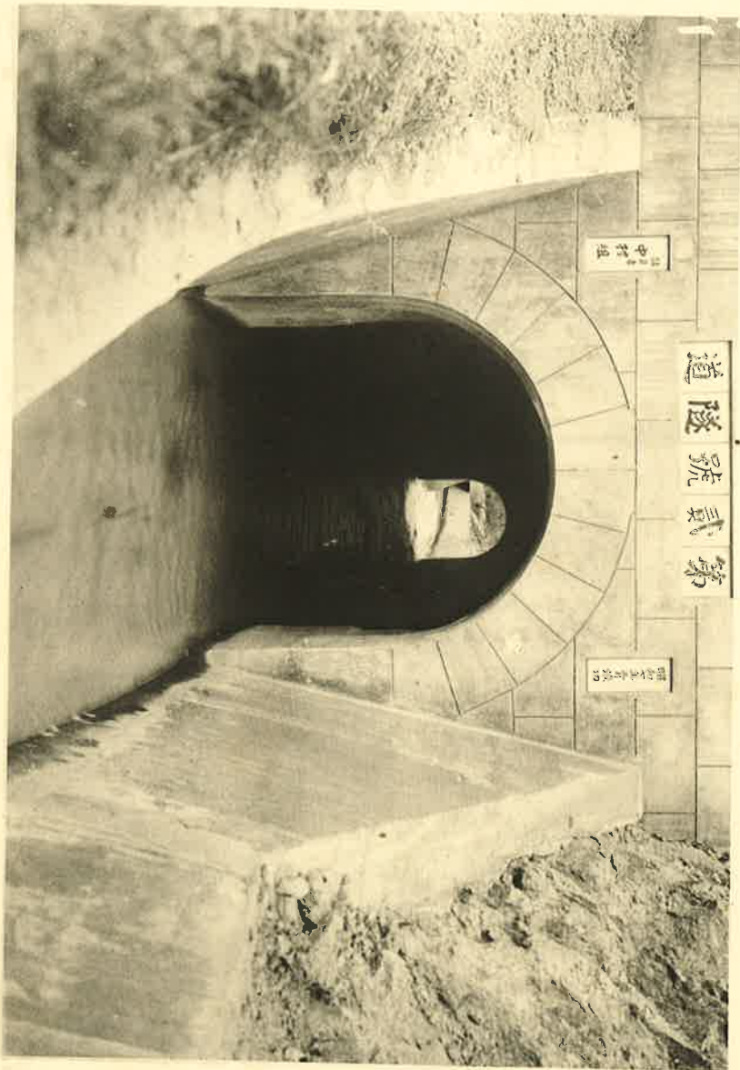
六引水路第二號隧水道
